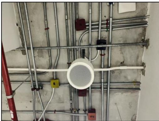
รูปที่ 57 อุปกรณ์ส่งเสียงแจ้งเหตุเพลิงไหม้
