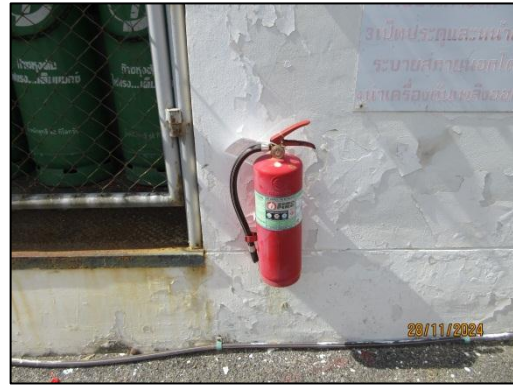
รูปที่ 53 (ต่อ) ถังดับเพลิงแบบมือถือ (Portable Fire Extinguisher)
