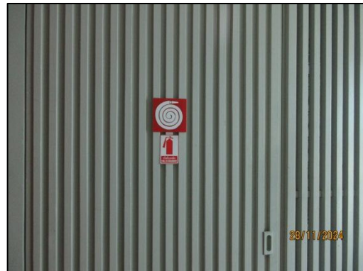
รูปที่ 52 ตู้สายน้ำดับเพลิง (Fire Hose Cabinet)
