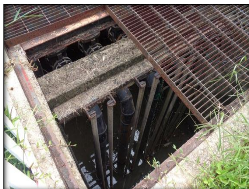
รูปที่ 35 เครื่องสูบน้ำบริเวณบ่อหน่วงน้ำ
