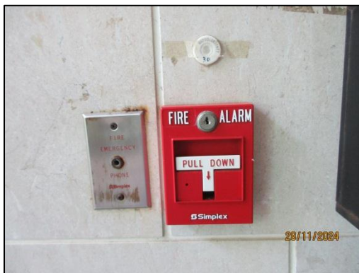
รูปที่ 56 ชุดกดแจ้งเหตุ (Manual Station)
