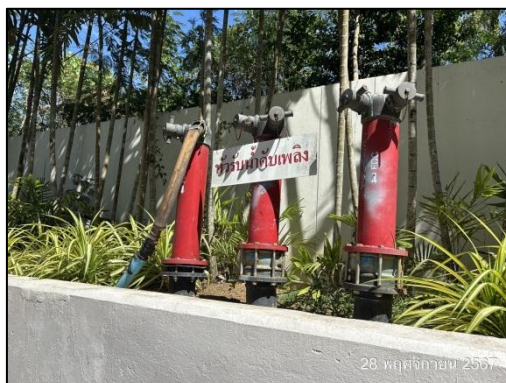
รูปที่ 49 หัวรับน้ำดับเพลิง (Fire Department Connection : FDC)
