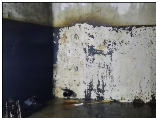
รูปที่ 27 ล้างถังเก็บน้ำ
