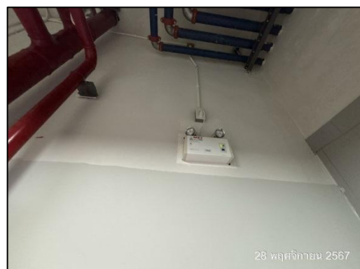
รูปที่ 61 ไฟฉุกเฉิน (Emergency Light)
