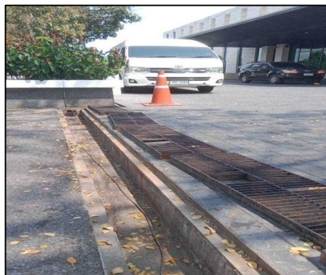
รูปที่ 36 ทำความสะอาดท่อระบายน้ำของโครงการ
