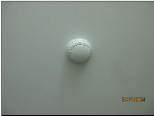
รูปที่ 58 (ต่อ) เครื่องตรวจจับควัน (Smoke Detector)
