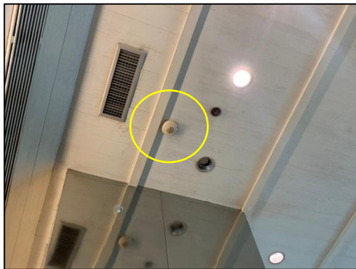
รูปที่ 59 เครื่องตรวจจับความร้อน (Heat Detector)
