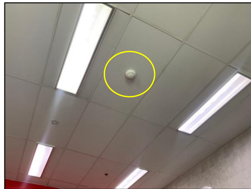
รูปที่ 59 เครื่องตรวจจับความร้อน (Heat Detector)
