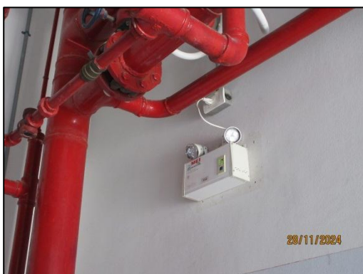
รูปที่ 61 ไฟฉุกเฉิน (Emergency Light)
