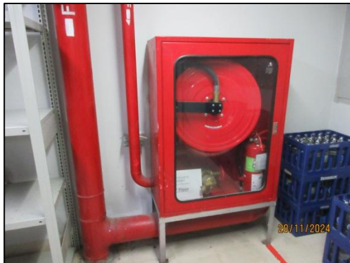
รูปที่ 52 ตู้สายน้ำดับเพลิง (Fire Hose Cabinet)
