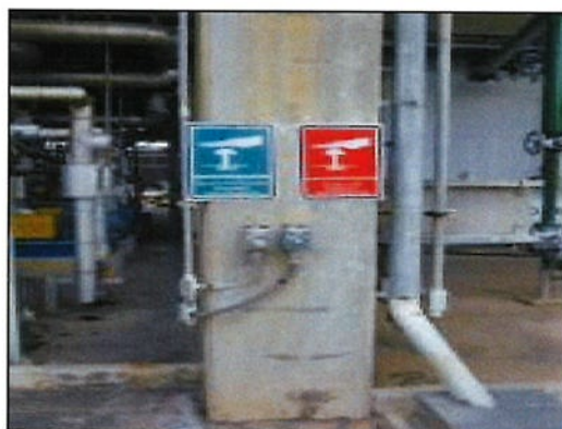
ภาพที่ 2.2-17 ปุ่มกดสัญญาณเตือนภัยภายในพื้นที่โครงการ
