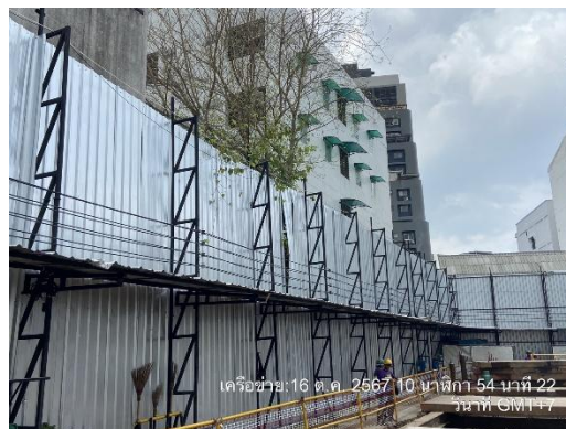
รูปที่ 4 รั้ว Metal Sheet
