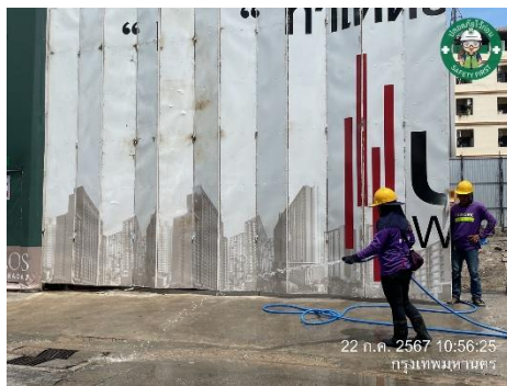
รูปที่ 16 ฉีดพรมน้ำบริเวณพื้นที่ก่อสร้าง
