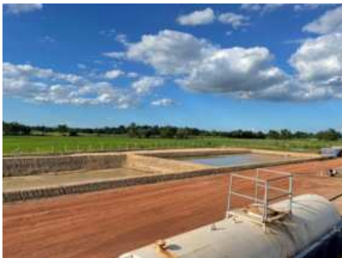
รูปที่ 3-5 ตัวอย่างบ่อที่ใช้พักเศษดินเศษหินจากการเจาะช่วงบน (Top hole cutting pit)
