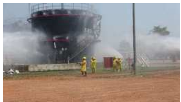
ภาพ 8 แสดงการเข้าดับเพลิงโดยรถดับเพลิงและการเปิดระบบการดับเพลิงโดยใช้หัวฉีดน้ำดับเพลิงแบบติดอยู่กับที่
