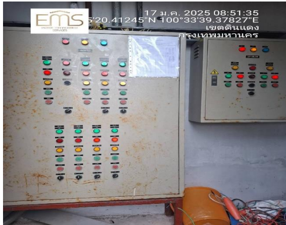
รูปที่ 28 ตู้ควบคุมระบบบำบัดน้ำเสีย
