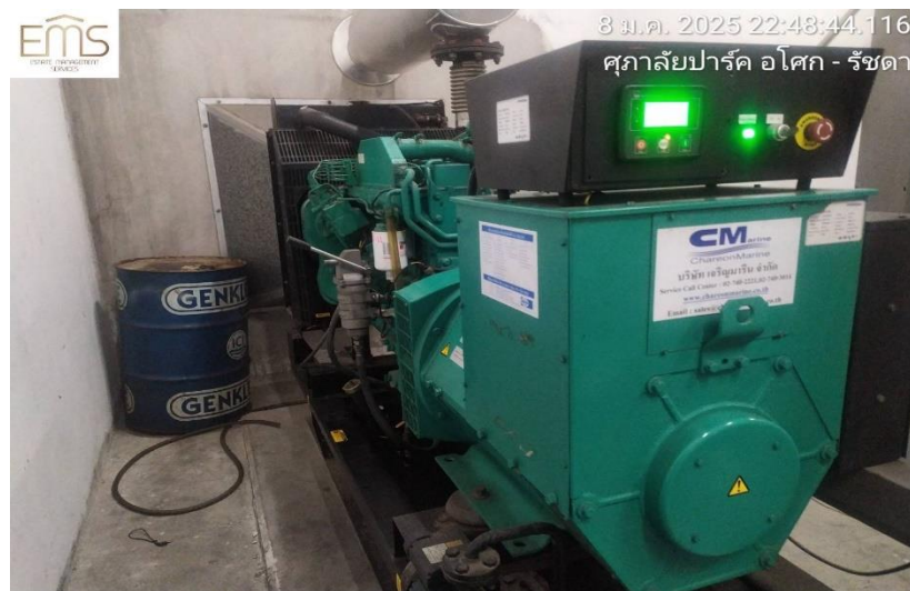
รูปที่ 14 เครื่องกำเนิดไฟฟ้าสำรอง
