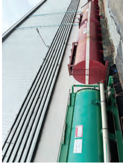
ถังรองรับน้ำเสียจากกระบวนการล้างทำความสะอาด (Storage Tank)
