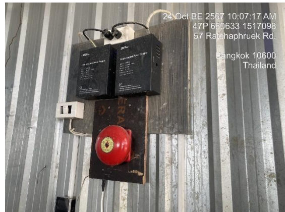
รูปที่ 39 อุปกรณ์แจ้งเตือนเหตุเพลิงไหม้
