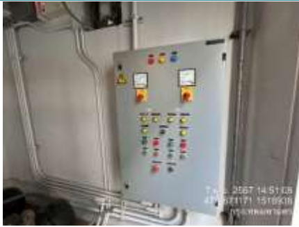
รูปที่ 20 ห้องควบคุมระบบบำบัดน้ำเสีย
