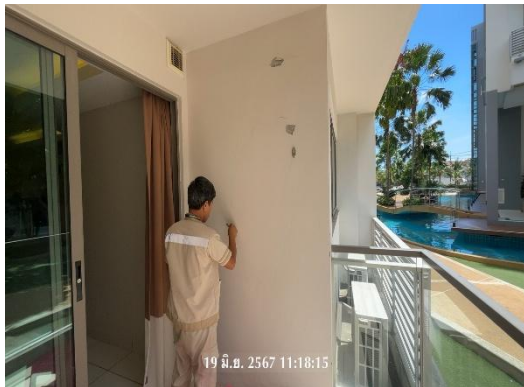
รูปภาพที่ 18 เจ้าหน้าที่ตรวจสอบอุดรอยร้าวผนัง ผ้าเปดาน ประตู หน้าต่าง
