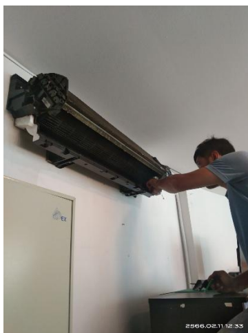
รูปภาพที่ 46 เจ้าหน้าที่ทำความสะอาดเครื่องปรับอากาศ
