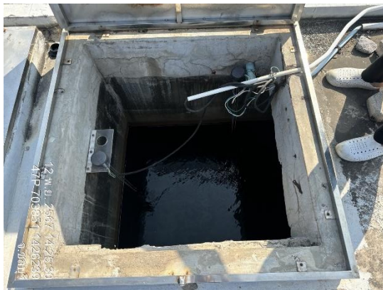
รูปภาพที่ 13 ถังสำรองน้ำใช้ภายในโครงการ
