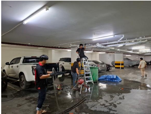
รูปภาพที่ 47 เจ้าหน้าที่ทำความสะอาดระบบท่อภายในโครงการ
