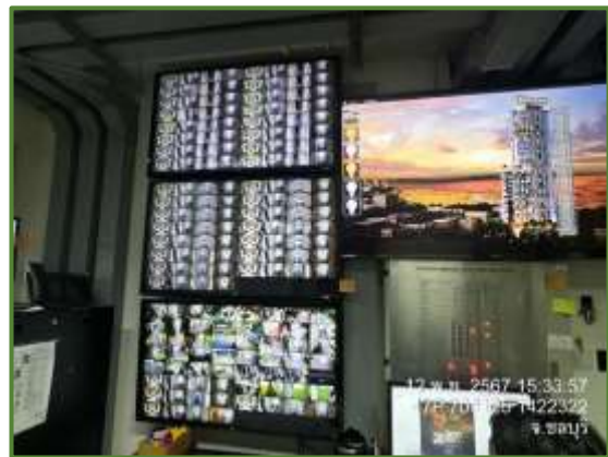
ภาพที่ 36 การติดตั้งกล้องวงจรปิด และระบบควบคุม
