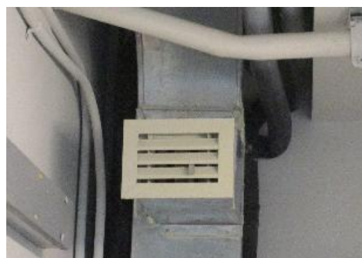
รูปที่ 11 เครื่องดูดกลิ่นห้องพักขยะ
