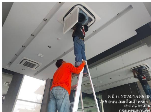
รูปที่ 57 การล้างเครื่องปรับอากาศในพื้นที่ส่วนกลาง
