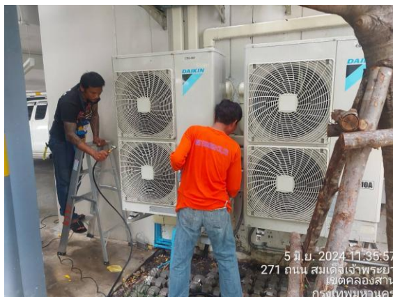
รูปที่ 57 การล้างเครื่องปรับอากาศในพื้นที่ส่วนกลาง
