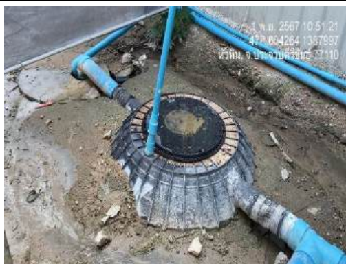
รูปที่ 35 ระบบบำบัดน้ำเสีย
