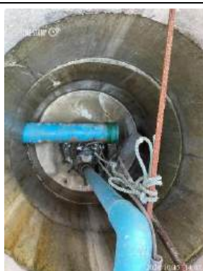
รูปที่ 23 เครื่องสูบน้ำ
