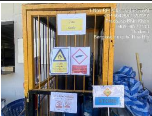
รูปที่ 38 พื้นที่จัดเก็บวัตถุไวไฟ และติดตั้งป้ายเตือนอันตราย
