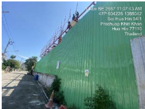
รูปที่ 1 รั้วทึบชั่วคราวโดยรอบบริเวณพื้นที่ก่อสร้าง ความสูงอย่างน้อย 2 เมตร
