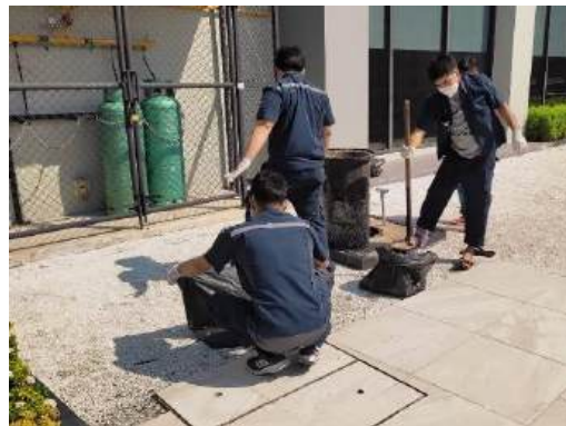
รูปที่ 13 เจ้าหน้าที่ทำความสะอาดถังดักไขมัน
