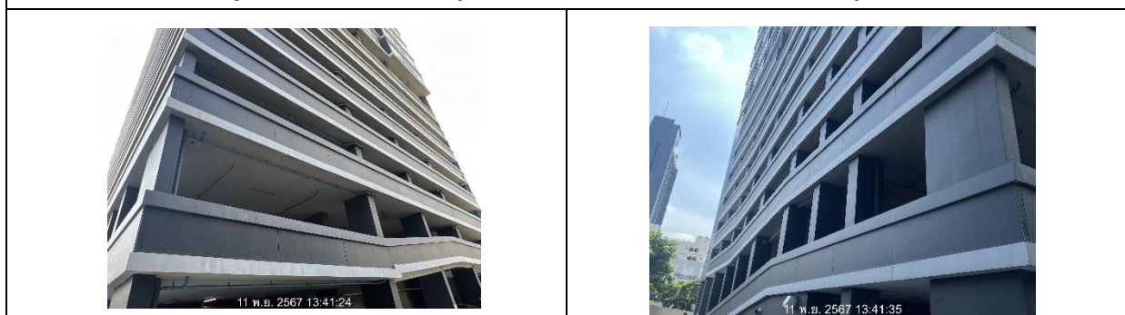
รูปที่ 6 ผนังอาคารอย่างน้อย 1 ด้าน ต้องมีช่องเปิดออกสู่ภายนอกได้
