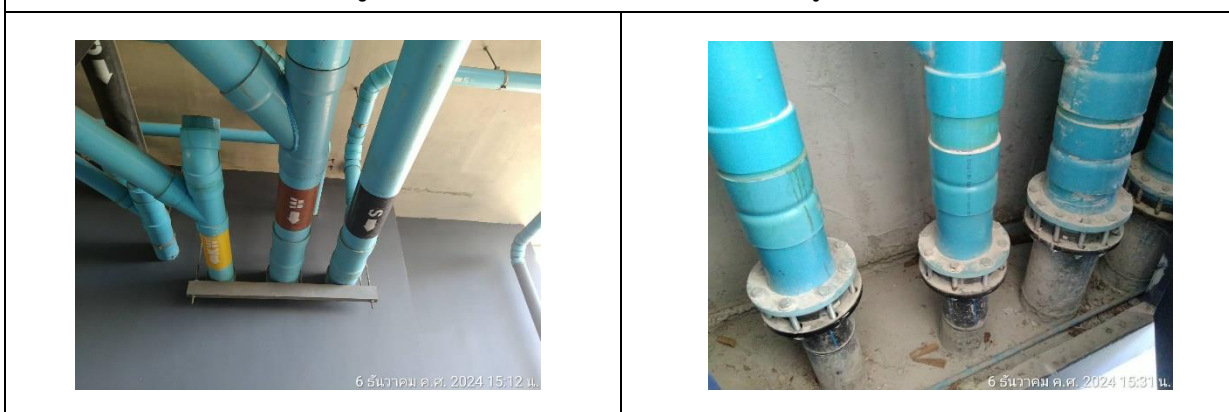
รูปที่ 24 ท่อรวบรวมน้ำห้องพัสดุฝอยเข้าสู่ระบบบำบัดน้ำเสียของโครงการ
