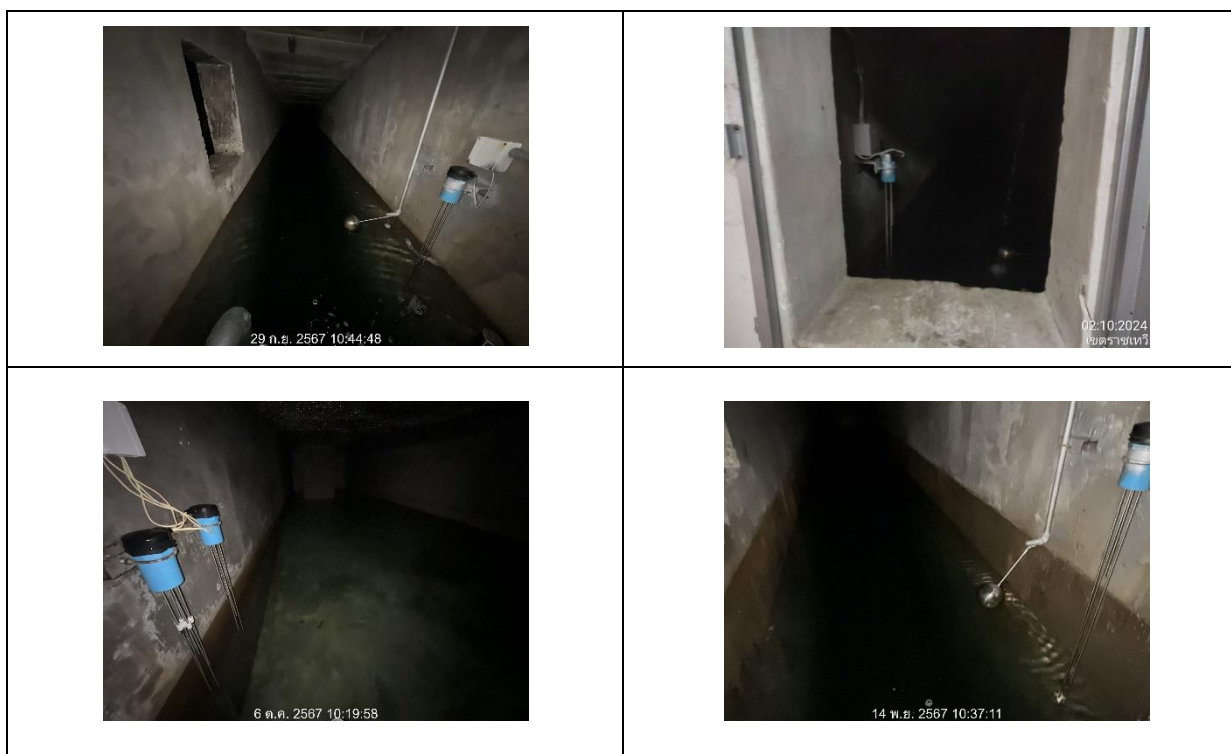
รูปที่ 34 ถังน้ำสำรองน้ำชั้นใต้ดิน และชั้นดาดฟ้า
