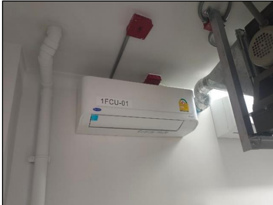
รูปที่ 2-5 เครื่องปรับอากาศและพัดลมดูดอากาศจากห้องพักมูลฝอยเปียก
