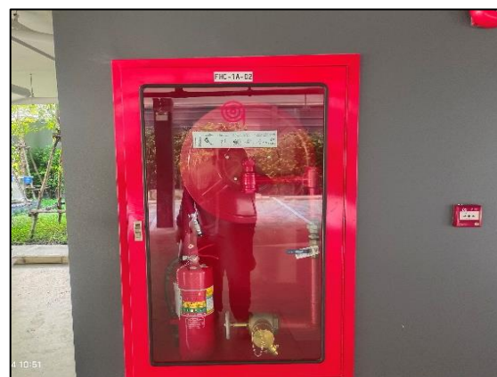
รูปที่ 2-26 ตู้เก็บสายฉีดน้ำดับเพลิง (Fire Hose Cabinet)
