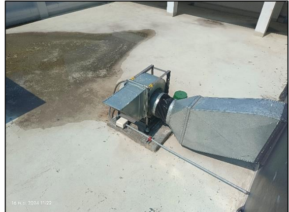
รูปที่ 2-5 เครื่องปรับอากาศและพัดลมดูดอากาศจากห้องพักมูลฝอยเปียก
