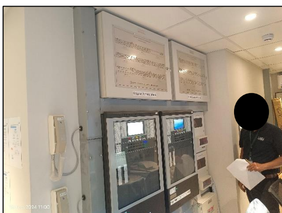
รูปที่ 2-31 แผงควบคุมระบบแจ้งเหตุอัคคีภัย (Fire Alarm Control Panel)
