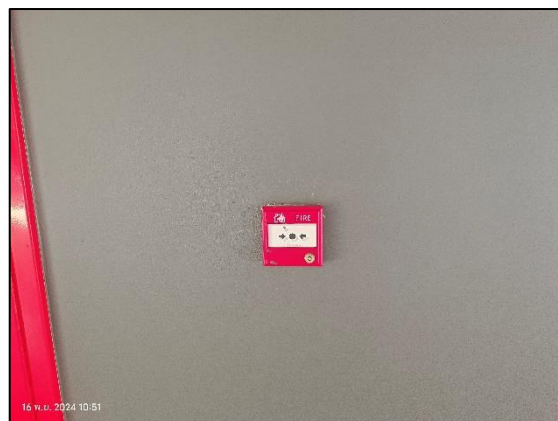
รูปที่ 2-25 อุปกรณ์แจ้งเหตุด้วยมือ (Manual Pull Station)
