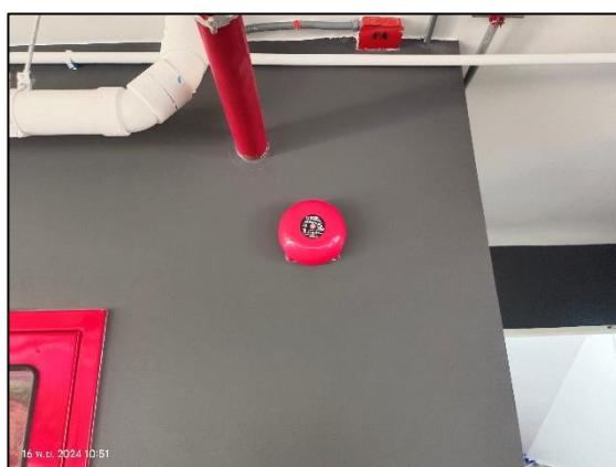
รูปที่ 2-32 กริ่งเตือนภัย (Alarm Bell)
