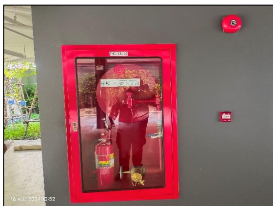
รูปที่ 2-26 ตู้เก็บสายฉีดน้ำดับเพลิง (Fire Hose Cabinet)
