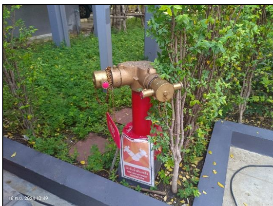
รูปที่ 2-27 หัวรับน้ำดับเพลิง (Fire Department Connection)
