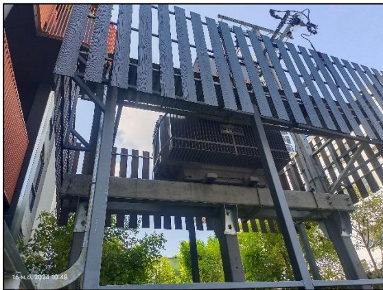
รูปที่ 2-9 หม้อแปลงไฟฟ้าและป้ายเตือนอันตรายไฟฟ้าแรงสูง
