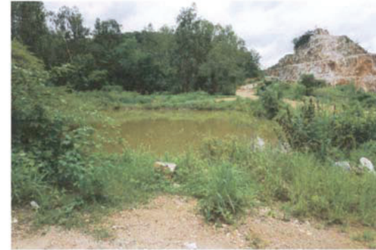
รูปที่ 9 แสดงบ่อลึกลับตะกอน รองรับน้ำฝนที่ไหลผ่านพื้นที่ทำเหมือง
