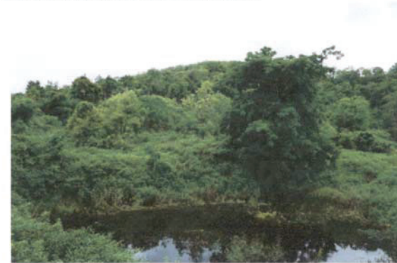
รูปที่ 10 แสดงบ่อลึกลับตะกอน รองรับน้ำฝนที่ไหลผ่านพื้นที่ทำเหมืองด้านทิศใต้ของพื้นที่โครงการฯ
