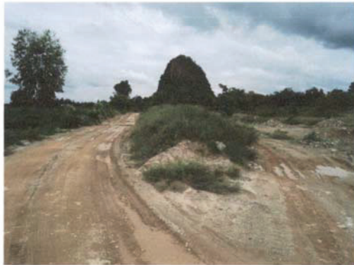
รูปที่ 8 แสดงคันทำนบดิน โดยที่ใช้เศษหินและดินปรับแต่งเป็นแนวกันน้ำรอบ บริเวณด้านตะวันออกทางเข้าโครงการฯ
