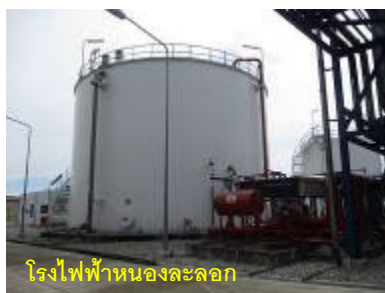
ภาพที่ 2-17 การจัดเตรียมน้ำสำรองไว้ใช้ในการดับเพลิงภายในโรงงาน
