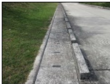
ภาพที่ 2-19 ท่อรวบรวมน้ำเสียที่เกิดจากกิจกรรมทุกประเภทในโรงงาน แยกจากท่อระบายน้ำฝน
