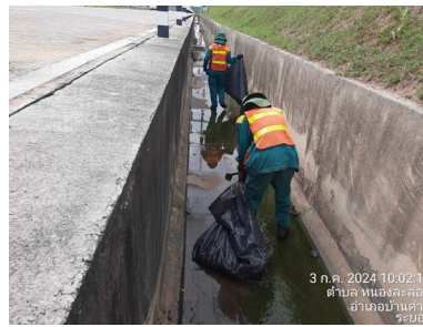
ภาพที่ 2-22 เจ้าหน้าที่ตรวจสอบดูแล และทำความสะอาดระบบระบายน้ำฝน
