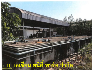
ภาพที่ 2-19 ท่อรวบรวมน้ำเสียที่เกิดจากกิจกรรมทุกประเภทในโรงงาน แยกจากท่อระบายน้ำฝน
