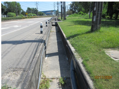
ภาพที่ 2-2 ระบบระบายน้ำฝนของโครงการ
