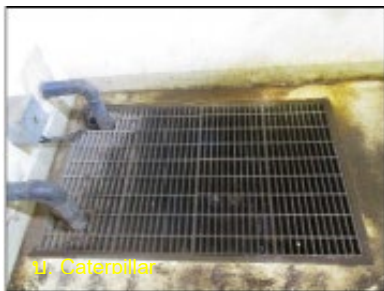
ภาพที่ 2-19 ท่อรวบรวมน้ำเสียที่เกิดจากกิจกรรมทุกประเภทในโรงงาน แยกจากท่อระบายน้ำฝน
