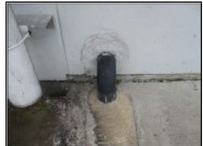
ภาพที่ 2-19 ท่อรวบรวมน้ำเสียที่เกิดจากกิจกรรมทุกประเภทในโรงงาน แยกจากท่อระบายน้ำฝน
