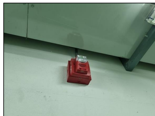
รูปที่ 69 เครื่องแจ้งเหตุโดยใช่มือ และกริ่งสัญญาณเตือนภัย
