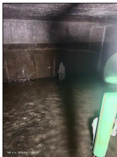
รูปที่ 34 ล้างทำความสะอาดถังเก็บน้ำสำรอง
