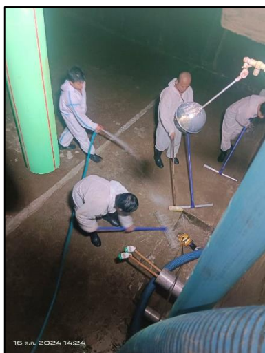
รูปที่ 34 ล้างทำความสะอาดถังเก็บน้ำสำรอง
