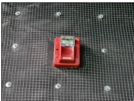
รูปที่ 69 เครื่องแจ้งเหตุโดยใช่มือ และกริ่งสัญญาณเตือนภัย
