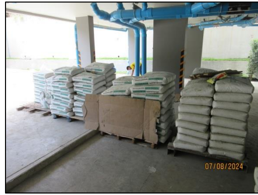
รูปที่ 22 ปูนซีเมนต์ผงที่นำเข้ามาภายในพื้นที่ก่อสร้างบรรจุภาชนะที่มิดชิด
