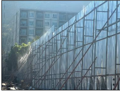
รูปที่ 15 สเปรย์น้ำบริเวณด้านบนรั้ว Metal Sheet รอบพื้นที่โครงการ
