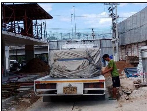
รูปที่ 14 ปิดคลุมท้ายรถบรรทุกด้วยผ้าใบทึบอย่างมิดชิด
