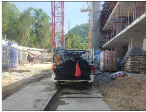
รูปที่ 45 ติดสัญญาณท้ายรถบรรทุก
