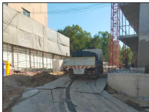
รูปที่ 14 ปิดคลุมท้ายรถบรรทุกด้วยผ้าใบทึบอย่างมิดชิด
