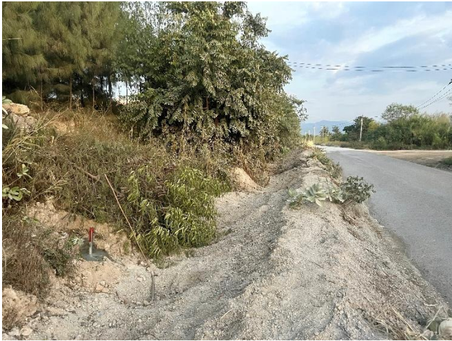
รูปที่ 2-24 คูระบายน้ำริมเส้นทางขนส่งแร่ภายนอก โครงการ
