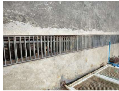
ภาพที่ 5-14 รางระบายน้ำ ติดตั้งตะแกรงดักขยะไว้เพิ่มเติมที่ปลายท่อ บ่อพักน้ำ
