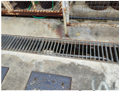
ภาพที่ 5-14 รางระบายน้ำ ติดตั้งตะแกรงดักขยะไว้เพิ่มเติมที่ปลายท่อ บ่อพักน้ำ
