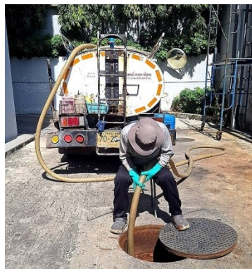
ภาพที่ 3-8 การสูบล้างจากบ่อกักเก็บตะกอน
