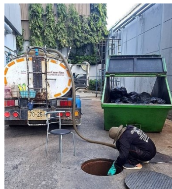
ภาพที่ 3-8 การสูบล้างจากบ่อกักเก็บตะกอน
