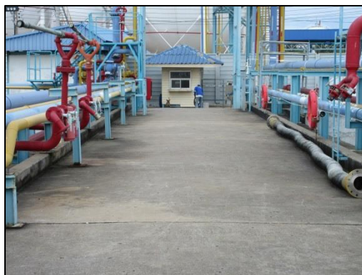
รูปที่ 5 ขอบคอนกรีตสูง 10 เซนติเมตร รอบพื้นที่ท่าเรือ
