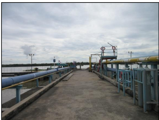
รูปที่ 5 ขอบคอนกรีตสูง 10 เซนติเมตร รอบพื้นที่ท่าเรือ
