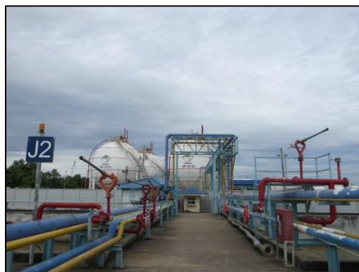
รูปที่ 13 หัวฉีดน้ำดับเพลิงบริเวณท่าเทียบเรือ
