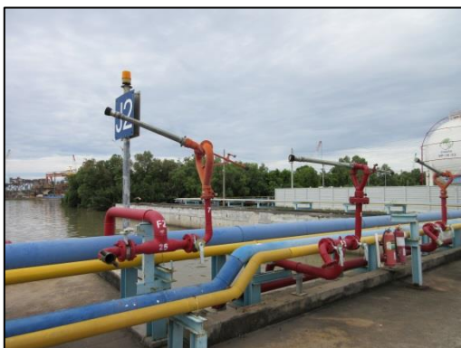
รูปที่ 13 หัวฉีดน้ำดับเพลิงบริเวณท่าเทียบเรือ
