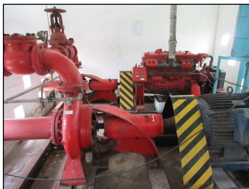
รูปที่ 14 ปั้มน้ำดับเพลิง
