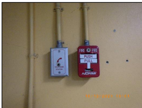
สัญญาณเตือนอัคคีภัย (Fire Alarm)
