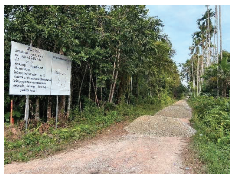
รูปที่ 2-7: การปรับปรุงถนนก่อนให้เป็นลาดยาง ออกสู่ถนนทางหลวงชนบทหมายเลข 4056
