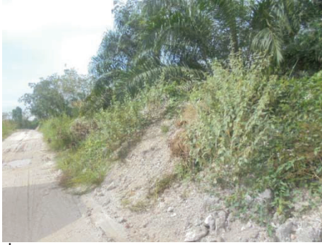
รูปที่ 2-15: ทำคันทำนบดินขนาดความกว้างด้านบนประมาณ 2 เมตร สูงประมาณ 2 เมตร และความกว้างด้านล่างประมาณ 8 เมตร
