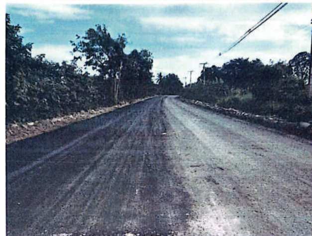
ภาพถ่ายขณะดำเนินการซ่อมแซมถนนลาดยางสายบ้านโนนชาด - บ้านวังยาว ( บริเวณก่อนถึงบ้านนายประสิทธิ์ บุญหลง บ้านวังคึกคัก หมู่ 13 ) ขนาดกว้าง 10 เมตร ระยะทางยาว 139 เมตร มีพื้นที่ซ่อมแซม 1,390 ตารางเมตร
