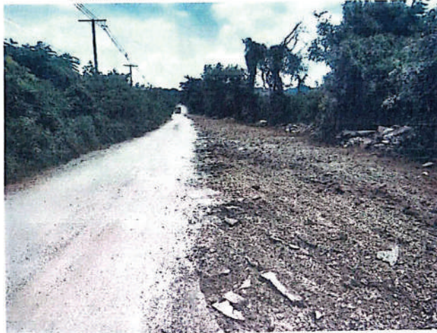
ภาพถ่ายขณะดำเนินการซ่อมแซมถนนลาดยางสายบ้านโนนชาด - บ้านวังยาว ( บริเวณก่อนถึงบ้านนายประสิทธิ์ บุญหลง บ้านวังศึกษา หมู่ 13 ) ขนาดกว้าง 10 เมตร ระยะทางยาว 139 เมตร มีพื้นที่ซ่อมแซม 1,390 ตารางเมตร
