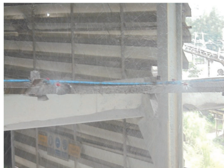
รูปที่ 2-16: การฉีดสเปรย์น้ำบริเวณจุดต่าง ๆ ของโรงโม่หิน
