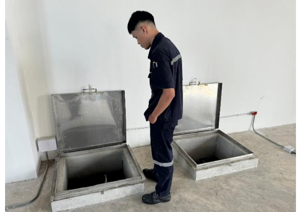
ถังเก็บน้ำสำรอง (คาดฟ้า)
