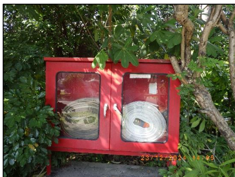
รูปที่ 2-37 ตู้เก็บอุปกรณ์ดับเพลิงภายนอกอาคาร
