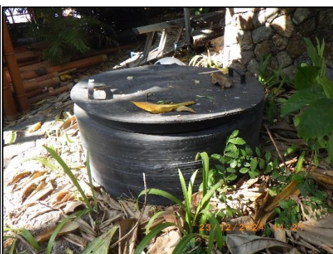
รูปที่ 2-5 บ่อพักน้ำเสียและน้ำฝน ที่ต่อเข้ากับ ระบบระบายน้ำของเมืองพัทยา
