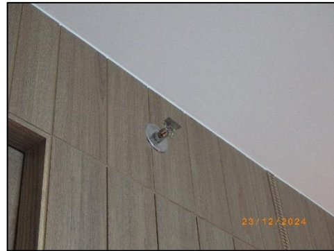
รูปที่ 2-46 หัวฉีดน้ำอัตโนมัติ
