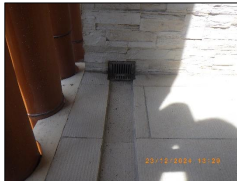
รูปที่ 2-24 รางระบายน้ำภายในอาคาร
