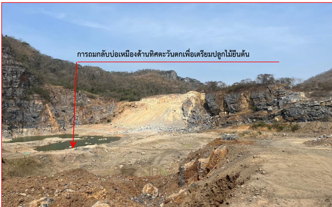
รูปที่ 8 การถมกลับพื้นที่บ่อเหมืองบางส่วนด้านทิศตะวันตก เพื่อเตรียมปลูกต้นไม้ในช่วงปีต่อไป
