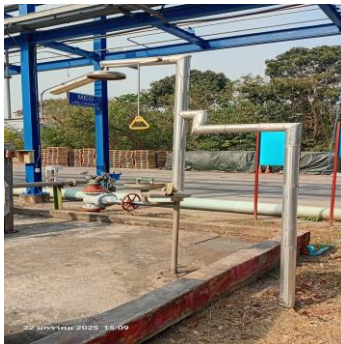
ภาพที่ 2.2-36 จุดชำระล้างร่างกายและล้างตาฉุกเฉิน (บริเวณที่มีการขนส่งหรือกักเก็บสารเคมี)
