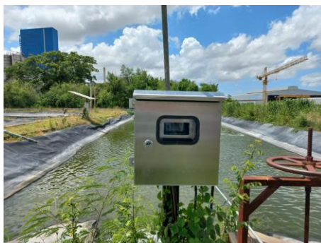
ภาพที่ 2.2-59 การติดตั้งอุปกรณ์ตรวจวัดค่าความนำไฟฟ้า (Conductivity Analyzer)
