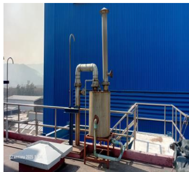
ภาพที่ 2.2-2 ระบบ Scrubber บริเวณปล่องหน่วยถลุงเตรียมสารเร่งปฏิกิริยา
