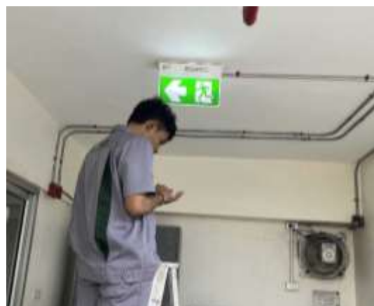
รูปที่ 3-8 การตรวจสอบสภาพความพร้อมใช้ของระบบไฟฉุกเฉินในโรงพยาบาล
