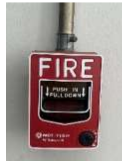
รูปที่ 3-9 การตรวจสอบสภาพความพร้อมใช้ของระบบสัญญาณแจ้งเหตุเพลิงไหม้
