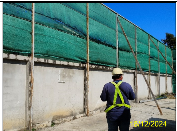
ก) ติดตั้งรั้วคอนกรีตความสูงไม่น้อยกว่า 2.50 เมตร และด้านบนติดตั้งรั้วโครงสร้างเหล็กพร้อมสแลนสูงไม่น้อยกว่า 3.00 เมตร เพื่อป้องกันการฟุ้งกระจายของฝุ่นละอองโดยรอบพื้นที่โครงการ
