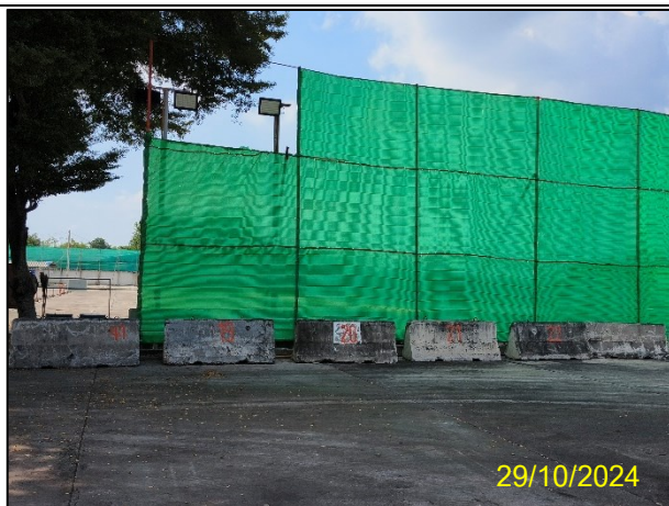
ก) ติดตั้งรั้วคอนกรีตความสูงไม่น้อยกว่า 2.50 เมตร และด้านบนติดตั้งรั้วโครงสร้างเหล็กพร้อมสแลนสูงไม่น้อยกว่า 3.00 เมตร เพื่อป้องกันการฟุ้งกระจายของฝุ่นละอองโดยรอบพื้นที่โครงการ
