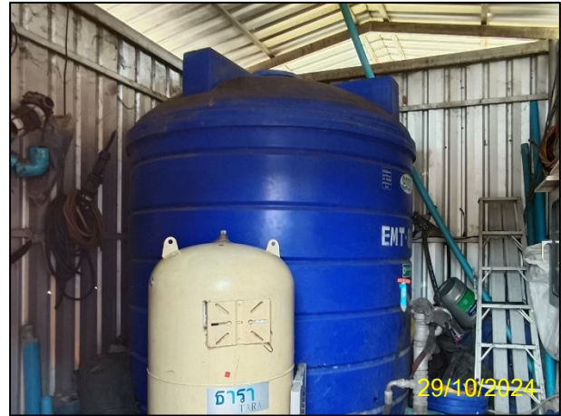
ข) การจัดให้มีถังเก็บน้ำชนิดวางบนดิน (สำหรับน้ำจากแม่น้ำป่าสัก) ขนาด 8.00 ลูกบาศก์เมตร
