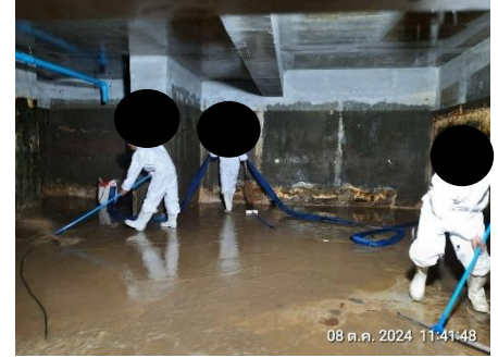
รูปที่ 2-36 เจ้าหน้าที่ล้างถังเก็บน้ำขึ้นใต้ดินและชั้นดาดฟ้า เมื่อวันที่ 8-9 ตุลาคม 2567
