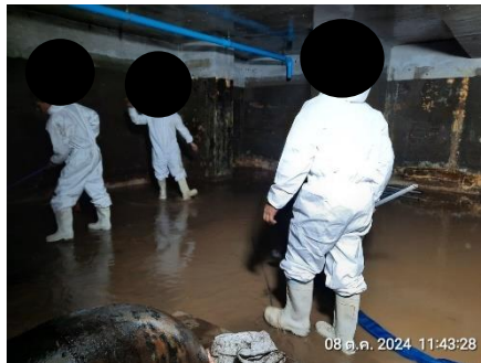
รูปที่ 2-36 เจ้าหน้าที่ล้างถังเก็บน้ำขึ้นใต้ดินและชั้นดาดฟ้า เมื่อวันที่ 8-9 ตุลาคม 2567
