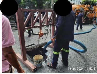
รูปที่ 2-37 สืบสิ่งปฏิกูลและอุดไขมัน เมื่อวันที่ 1 ตุลาคม 2567
