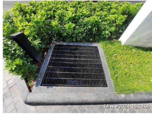
รูปที่ 2-23 ติดตั้งตะแกรงดักขยะ
