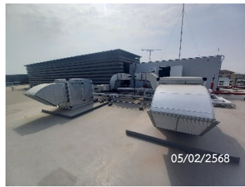
การระบายอากาศภายในอาคารด้วยระบบ HVAC ช่องระบายอากาศพื้นที่จอดรถ
