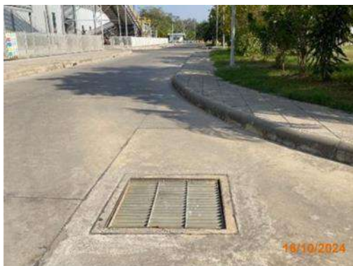
รูปที่ 2-8 ระบบระบายน้ำฝนของโรงงาน
