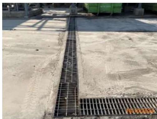
รูปที่ 2-10 ระบบระบายน้ำเสียของโรงงาน
