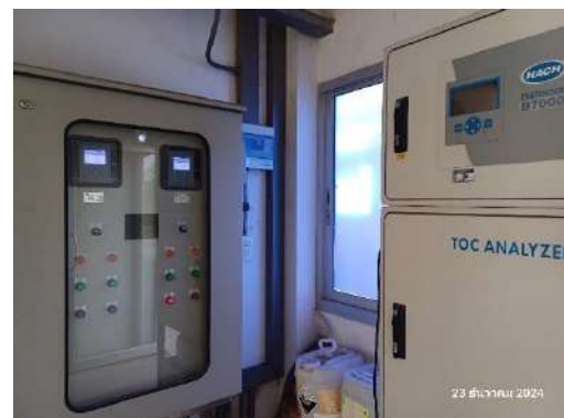
รูปที่ 2-15 การติดตั้งเครื่องตรวจวัด DO online และ BOD/COD online บริเวณบ่อพักน้ำทิ้ง (Holding Pond)
