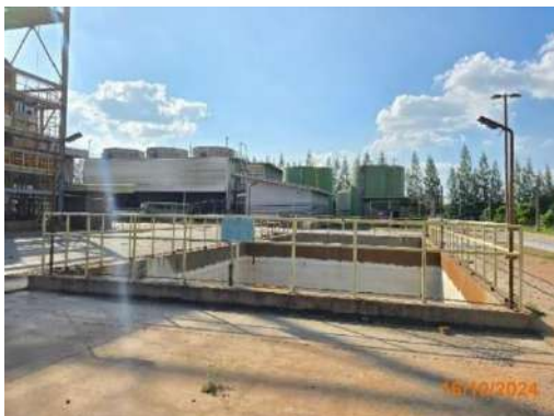
รูปที่ 2-4 บ่อพักน้ำทิ้งฉุกเฉินของโรงงาน
