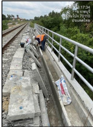
รูปที่ 2-7 งานก่อสร้างท่อรองรับ Cable Trench and Laying Cable ช่วงข้ามสะพานรถไฟ บริเวณสถานีนครปฐม
