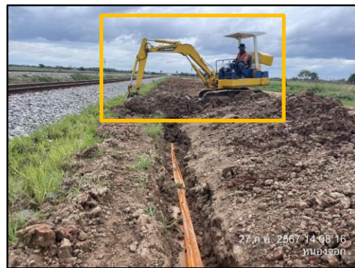
รูปที่ 2-10 การขุดเปิดและปิดหน้าดินงานก่อสร้าง Cable Trench and Laying Cable
