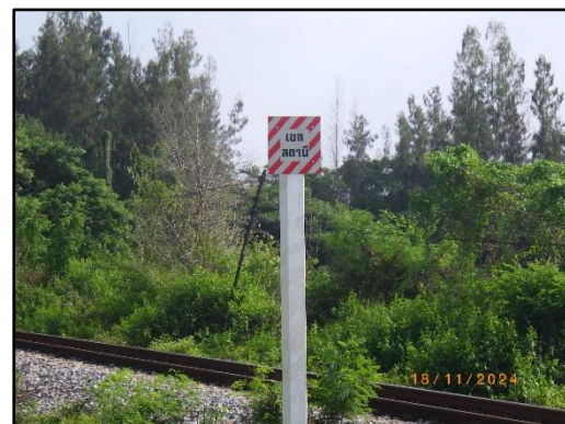
รูปที่ 2-26 ติดตั้งป้ายสัญญาณสำหรับพนักงานขับรถไฟ
