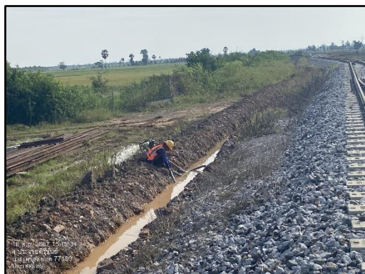
รูปที่ 2-11 การจัดเตรียมเครื่องสูบน้ำ กรณีพื้นที่โดยรอบเกิดภาวะน้ำท่วม
