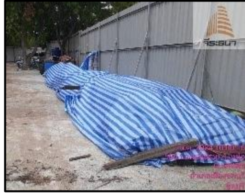
รูปที่ 20 การเก็บกองวัสดุก่อสร้างหรือเศษวัสดุที่เหลือใช้ภายในโครงการ ปิดคลุมด้วยผ้าใบมิดชิด
