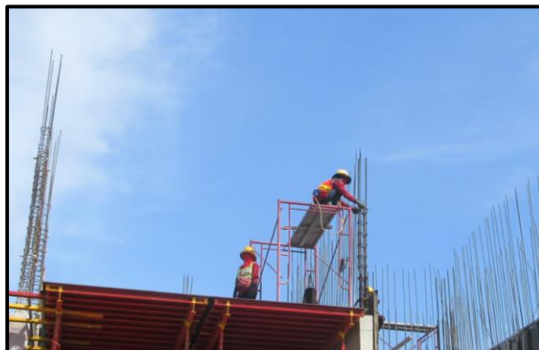
รูปที่ 53 นั่งร้านภายในพื้นที่ก่อสร้าง
