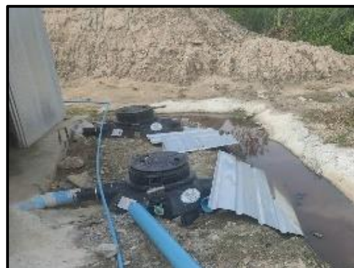
รูปที่ 1-4 ถังบำบัดน้ำเสียสำเร็จรูปบริเวณพื้นที่ก่อสร้างและบ้านพักคนงาน
