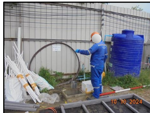
รูปที่ 75 การตรวจวัดคุณภาพน้ำทิ้ง บริเวณบ่อกักน้ำชั่วคราวสุดท้ายก่อนระบายออกสู่ระบบน้ำทิ้งด้านหน้าโครงการ
