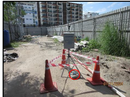
รูปที่ 74 การตรวจวัดความสั่นสะเทือน บริเวณพื้นที่ก่อสร้าง
