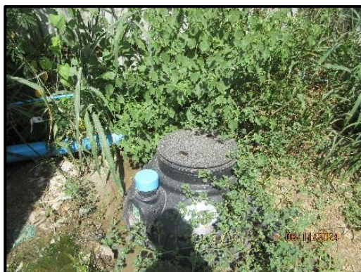
รูปที่ 1-4 ถังบำบัดน้ำเสียสำเร็จรูปบริเวณพื้นที่ก่อสร้างและบ้านพักคนงาน
