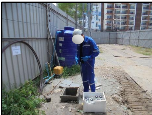
รูปที่ 75 การตรวจวัดคุณภาพน้ำทิ้ง บริเวณบ่อกักน้ำชั่วคราวสุดท้ายก่อนระบายออกสู่ระบบน้ำทิ้งด้านหน้าโครงการ
