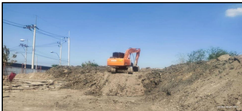
รูปที่ 23 กองดินที่ขุดออกจากการก่อสร้างฐานรากเก็บไว้ในพื้นที่ปิดล้อมเป็นสัดส่วนไว้ในพื้นที่เฉพาะ
