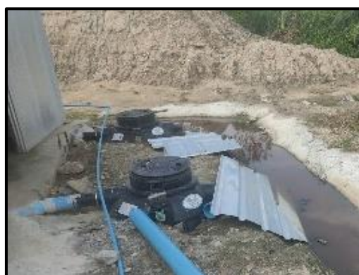
รูปที่ 34 ถังบำบัดน้ำเสียสำเร็จรูปบ้านพักคนงาน
