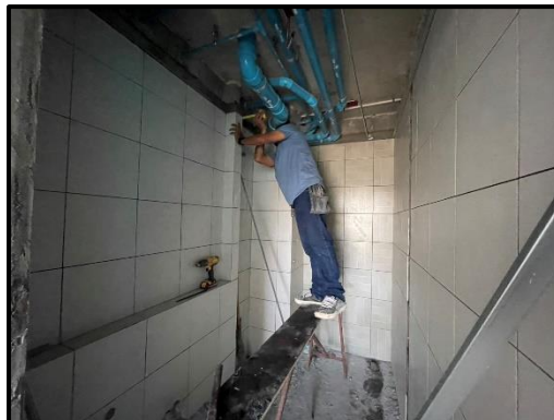
รูปที่ 37 ผู้รับเหมาตรวจสอบการรั่วซึมของระบบท่อ และการรั่วซึมจากห้องน้ำ ห้องส้วม
