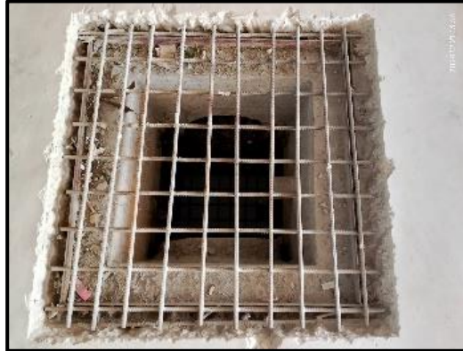
รูปที่ 40 ตะแกรงดักขยะ
