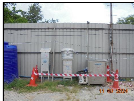
รูปที่ 72 การตรวจวัดปริมาณฝุ่นละออง บริเวณพื้นที่ก่อสร้าง
