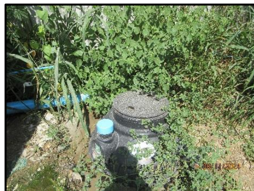
รูปที่ 33 ถังบำบัดน้ำเสียสำเร็จรูปบริเวณพื้นที่ก่อสร้าง
