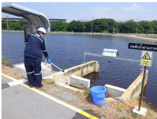
บ่อพักน้ำทิ้งหลังผ่านระบบบำบัดน้ำเสียสำเร็จรูปก่อนระบายออกนอกพื้นที่โครงการ
