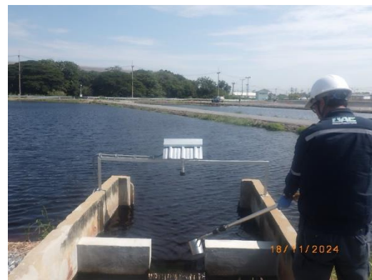
บ่อพักน้ำทิ้งหลังผ่านระบบบำบัดน้ำเสียสำเร็จรูปก่อนระบายออกนอกพื้นที่โครงการ
