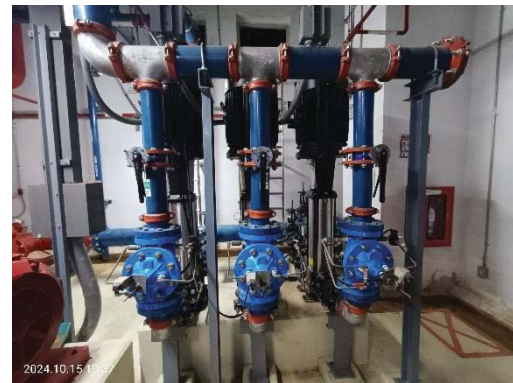
เครื่องสูบน้ำ Reuse
