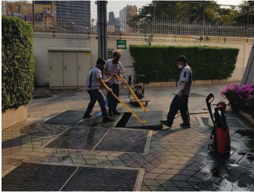
การทำความสะอาดและตักเศษขยะออกจากตะแกรงดักขยะ
