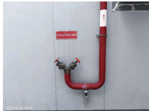
หัวจ่ายน้ำดับเพลิงชั้นดาดฟ้า (Roof Manifold)
