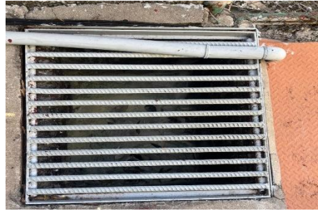
ภาพที่ 22 ตะแกรงดักขยะ
