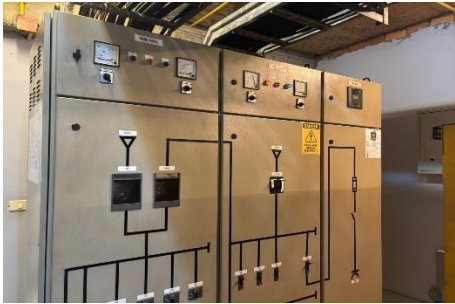
ภาพที่ 43 ตู้ตัดกระแสไฟอัตโนมัติ
