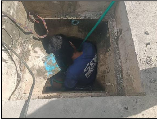
รูปที่ 24 ทำความสะอาดชุดล้างทำความสะอาดระบบระบายน้ำทิ้ง
