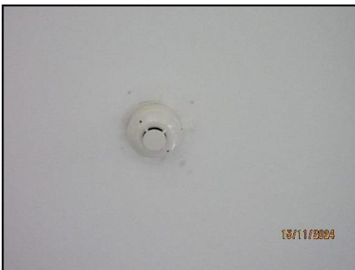
รูปที่ 30 เครื่องตรวจจับควัน
