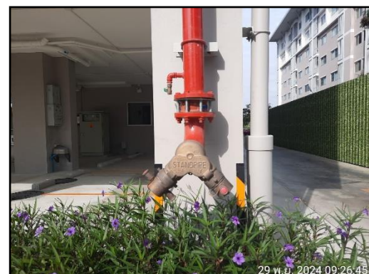
รูปที่ 46 หัวรับน้ำดับเพลิงภายในโครงการ
