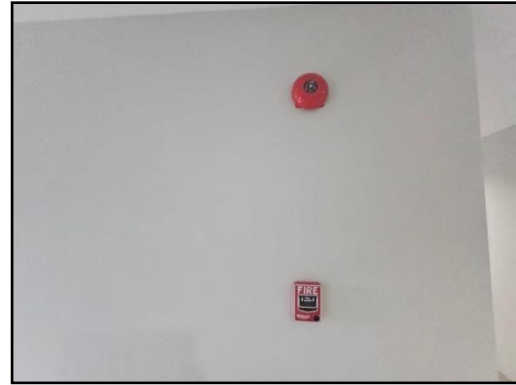
รูปที่ 29 (ต่อ) เครื่องส่งสัญญาณไฟแบบกริ่ง (Alarm Bell) และอุปกรณ์แจ้งเหตุ (Switch Board)
