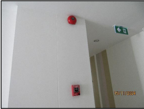
รูปที่ 29 (ต่อ) เครื่องส่งสัญญาณไฟแบบกริ่ง (Alarm Bell) และอุปกรณ์แจ้งเหตุ (Switch Board)
