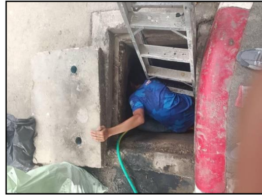
รูปที่ 24 ทำความสะอาดชุดล้างทำความสะอาดระบบระบายน้ำทิ้ง
