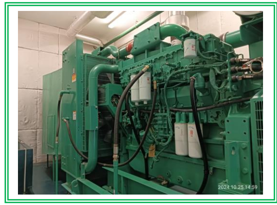
เครื่องกำเนิดไฟฟ้าฉุกเฉินส่วนโรงแรม
