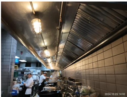
เครื่องดูดควันสำหรับระบายอากาศจากห้องอาหาร
