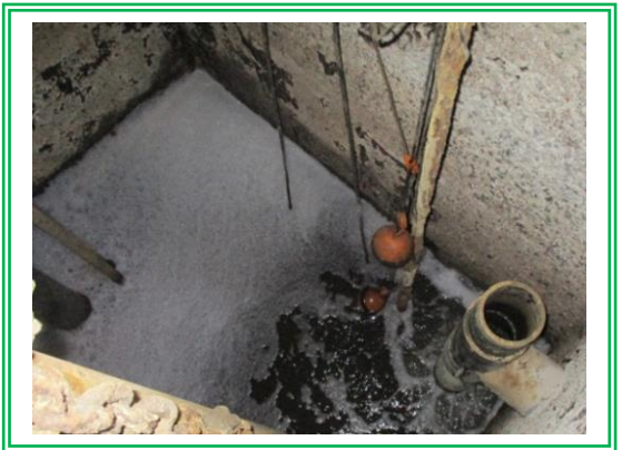
รูปที่ 3.2-6 บ่อรวบรวมน้ำเสียส่วนอาคารศูนย์การค้า และสำนักงาน
