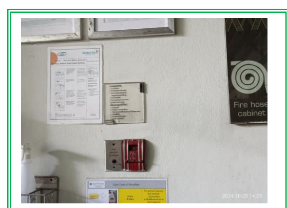
รูปที่ 3.2-37 สวิตช์กดแจ้งเหตุด้วยมือ (Fire Alarm Manual Station)
