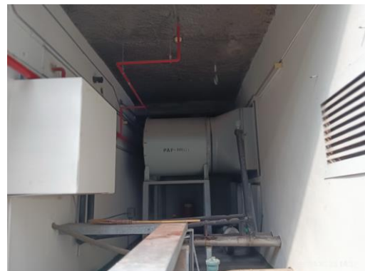
พัดลมดูดอากาศสำหรับบันไดหนีไฟของอาคาร
