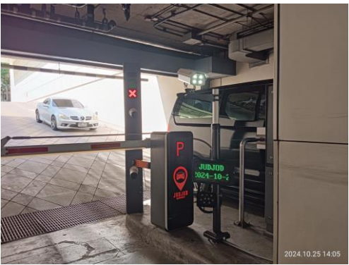
รูปที่ 3.2-2 เครื่องควบคุมสัญญาณไฟเตือนบริเวณลานจอดรถ
