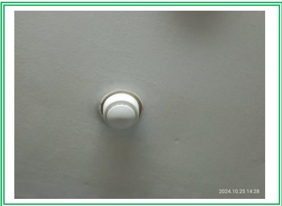
รูปที่ 3.2-36 เครื่องตรวจจับความร้อน (Heat Detector)
