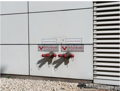
หัวรับน้ำดับเพลิง (Fire Department Connections)
