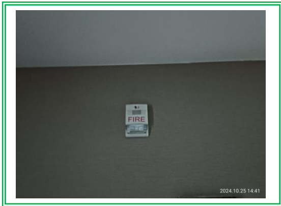
รูปที่ 3.2-34 กริ่งสัญญาณแจ้งเหตุ (Fire Alarm Bell)
