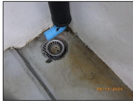
รูปที่ 2-31 ตะแกรงครอบรูระบายน้ำทิ้งภายในอาคาร
