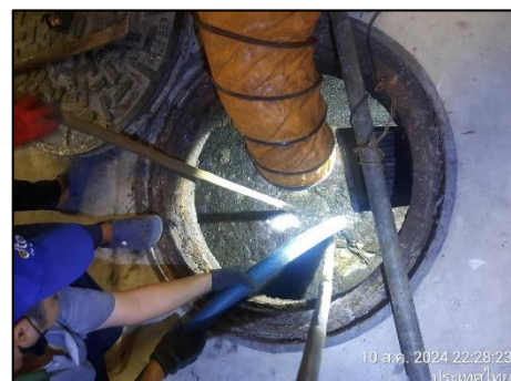
รูปที่ 2-80 การสุบสิ่งปฏิกูลจากบ่อบำบัดน้ำเสีย
