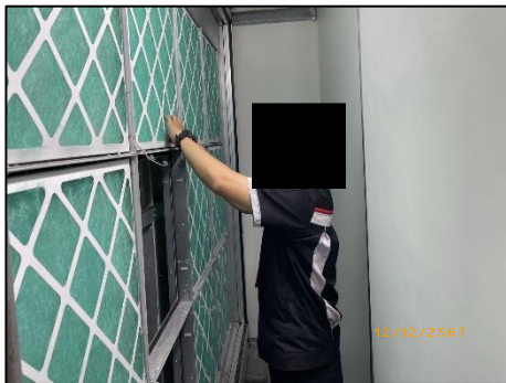
รูปที่ 2-50 การทำความสะอาดระบบเครื่องปรับอากาศ
