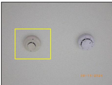
รูปที่ 2-56 เครื่องตรวจจับควัน
