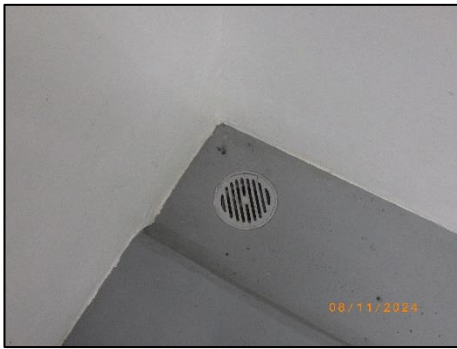
รูปที่ 2-31 ตะแกรงครอบรูระบายน้ำทิ้งภายในอาคาร
