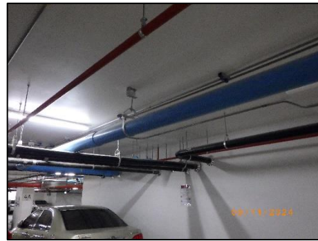
รูปที่ 2-25 ท่อระบายก๊าซมีเทนไปบำบัดโดยวิธี Biological Oxidation
