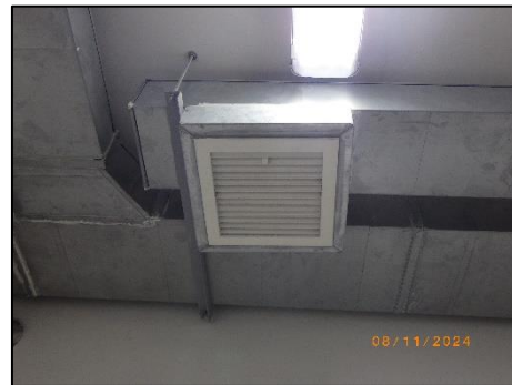
รูปที่ 2-40 ระบบดูดอากาศจากห้องพักขยะรวม
