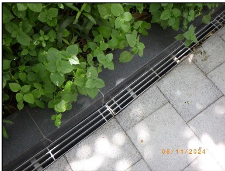
รูปที่ 2-32 ตะแกรงครอบท่อระบายน้ำฝน ภายนอกอาคาร
