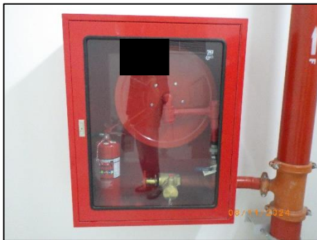
รูปที่ 2-62 ตู้เก็บสายฉีดน้ำดับเพลิงพร้อมอุปกรณ์
