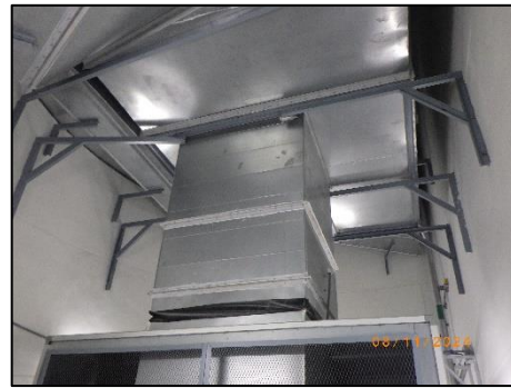
รูปที่ 2-14 พัฒนาระบายอากาศชั้นใต้ดิน
