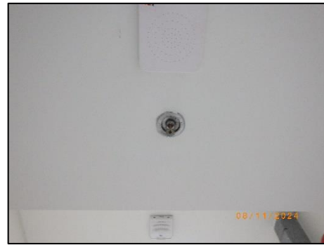
รูปที่ 2-61 หัวกระจายน้ำดับเพลิงอัตโนมัติ
