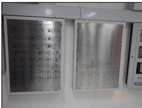
รูปที่ 2-54 แผงควบคุมระบบแจ้งเหตุอัคคีภัย
