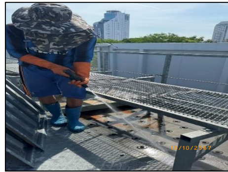
รูปที่ 2-53 การทำความสะอาดห่อหุ้มเย็น
