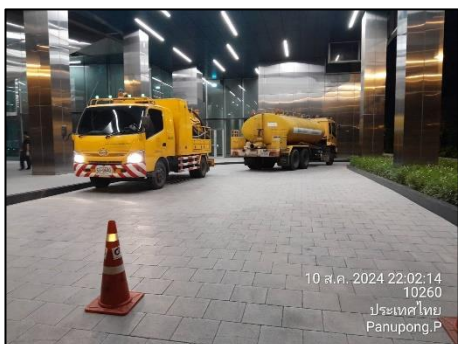
รูปที่ 2-80 การสุบสิ่งปฏิกูลจากบ่อบำบัดน้ำเสีย
