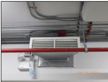
รูปที่ 2-40 ระบบดูดอากาศจากห้องพักขยะรวม
