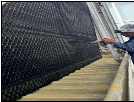
รูปที่ 2-53 การทำความสะอาดห่อหุ้มเย็น
