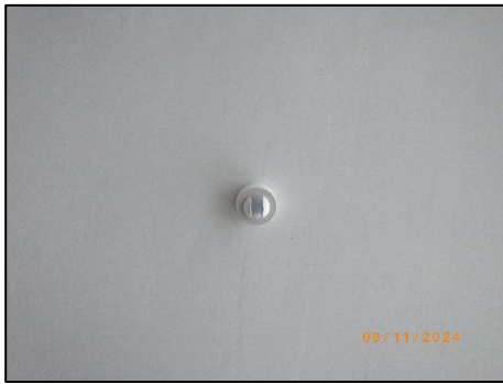
รูปที่ 2-69 เซ็นเซอร์ตรวจจับความเคลื่อนไหว บริเวณลานจอดรถ
