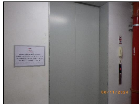
รูปที่ 2-63 ลิฟต์ดับเพลิง
