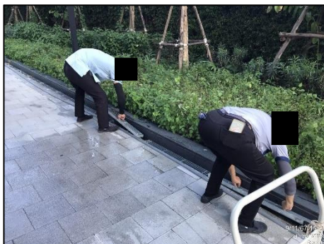
รูปที่ 2-30 การทำความสะอาดระบบท่อระบายน้ำ
