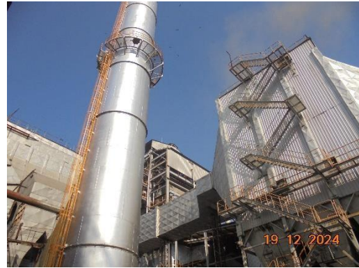
รูปที่ 1 ปล่องหม้อไอน้ำ ชุดที่ 5-6 และระบบบำบัดมลพิษทางอากาศ
