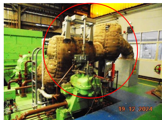
รูปที่ 27 ป้ายเตือนบริเวณที่เป็นแหล่งกำเนิดความร้อนสูงและการติดฉนวนป้องกันความร้อน
