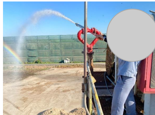
รูปที่ 37 หัวฉีดน้ำดับเพลิง บริเวณพื้นที่กองเก็บเชื้อเพลิง
