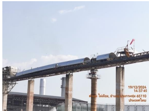
รูปที่ 7 ระบบสายพานลำเลียงเชื้อเพลิง
