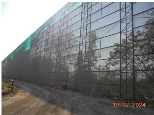
รูปที่ 4 ติดตั้งตาข่ายล้อมรอบพื้นที่ลานกองขานอ้อย
