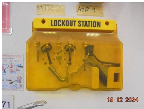
รูปที่ 35 อุปกรณ์ระบบ Log out-Tag out
