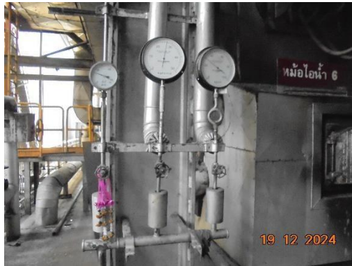
รูปที่ 43 มาตรการวัดความดันไอน้ำ/มาตรการระดับน้ำ
