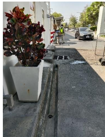
รูปที่ 1.5-1 ท่อรวบรวมน้ำเสียเข้าสู่ระบบบำบัดน้ำเสีย
