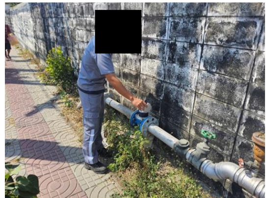
รูปที่ 3.1-3 ติดตั้งมาตรวัดน้ำ -เจ้าหน้าที่ดูแลระบบและเส้นท่อภายในโครงการ
