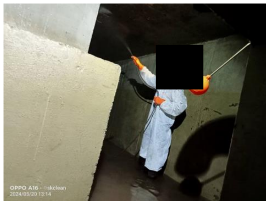
รูปที่ 3.1-4 การทำความสะอาดถังเก็บน้ำสำรอง
