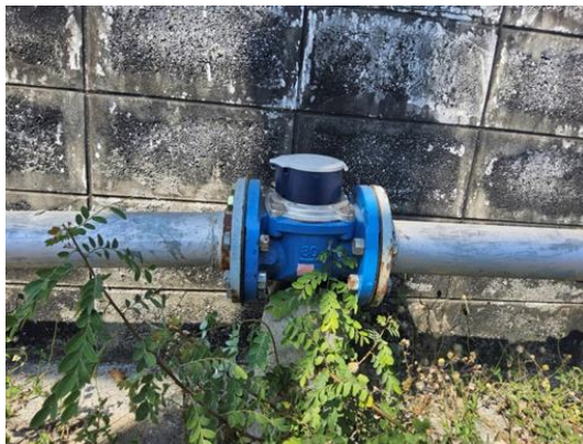
รูปที่ 3.1-3 ติดตั้งมาตรวัดน้ำ -เจ้าหน้าที่ดูแลระบบและเส้นท่อภายในโครงการ
