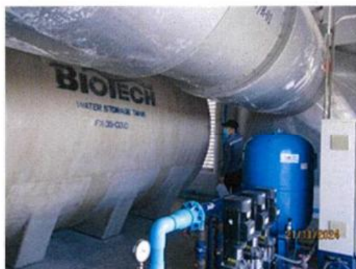
ภาพถ่ายที่ 2.2-61 ถังสำรองน้ำใช้บนหลังคา
