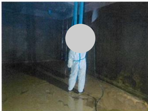
ภาพถ่ายที่ 2.2-79 การล้างทำความสะอาดถึงเก็บน้ำใช้
