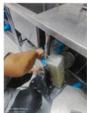
ภาพถ่ายที่ 2.2-20 เจ้าหน้าที่ตักไขมันในบ่อดักไขมัน (Grease trap tank)
