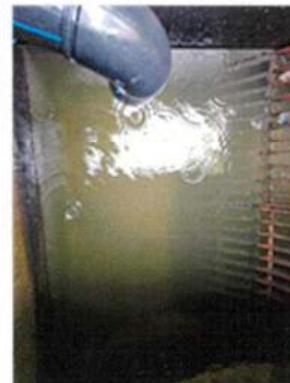
ภาพถ่ายที่ 2.2-65 ตะแกรงดักขยะที่บ่อตรวจสอบสภาพน้ำ
