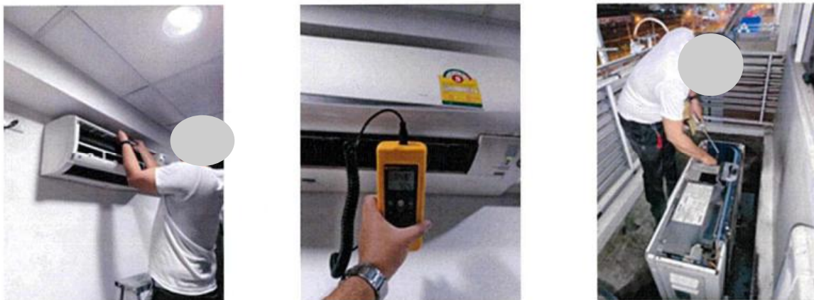
ภาพถ่ายที่ 2.2-78 การตรวจสอบช่องระบายอากาศภายในอาคาร
