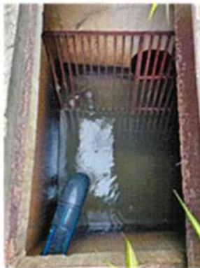
ภาพถ่ายที่ 2.2-65 ตะแกรงดักขยะที่บ่อตรวจสอบสภาพน้ำ
