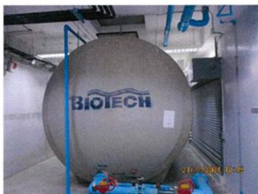
ภาพถ่ายที่ 2.2-61 ถังสำรองน้ำใช้บนหลังคา
