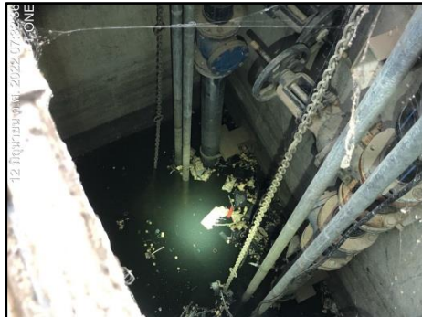
รูปที่ 2-44 เครื่องสูบน้ำเพื่อควบคุมอัตราการระบายน้ำฝนออกจากบ่อหน้า
