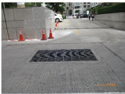
รูปที่ 2-29 ตะแกรงดักมูลฝอย บริเวณทางเข้าโครงการฯ ฟังถนนวิฑู
