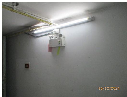
รูปที่ 2-46 ไฟฉุกเฉินภายในอาคาร
