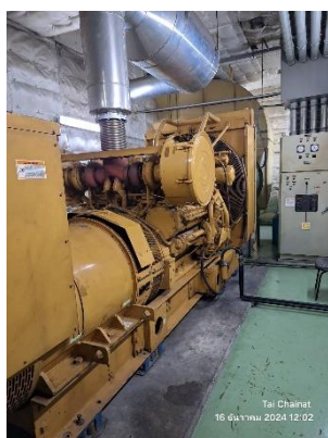
รูปที่ 2-47 ระบบไฟฟ้าสำรอง
