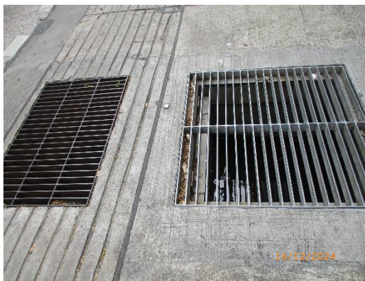
รูปที่ 2-31 ตะแกรงดักมูลฝอย บริเวณทางเข้าโครงการฯ ฝั่งซอยร่วมฤดี
