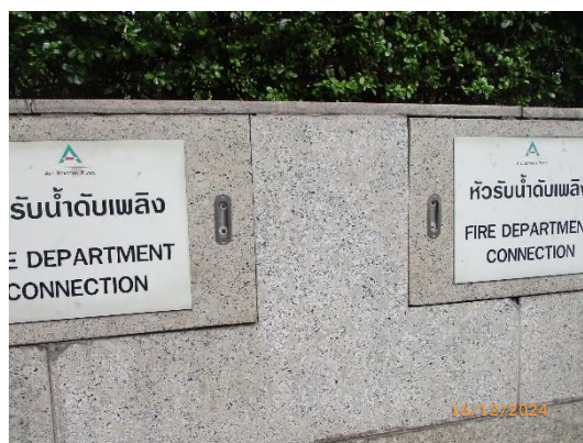
รูปที่ 2-36 ที่เก็บหัวรับน้ำดับเพลิงภายนอกอาคาร
