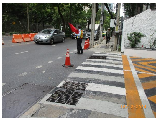
รูปที่ 2-30 ตะแกรงดักมูลฝอย บริเวณทางออกโครงการฯ ฟังถนนวิฑู
