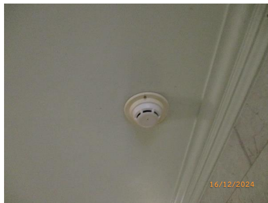
รูปที่ 2-44 อุปกรณ์ตรวจจับควัน
