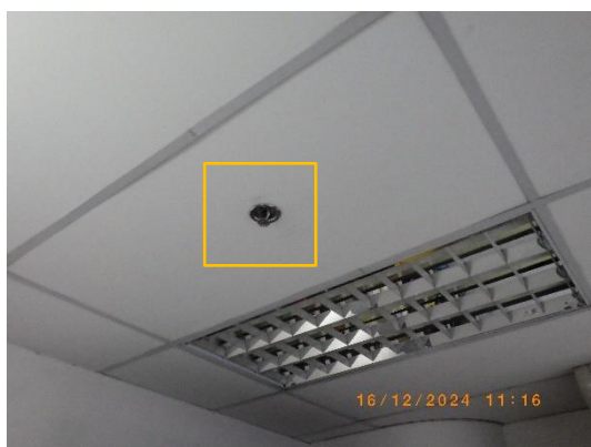
รูปที่ 2-45 หัวกระจายน้ำดับเพลิง
