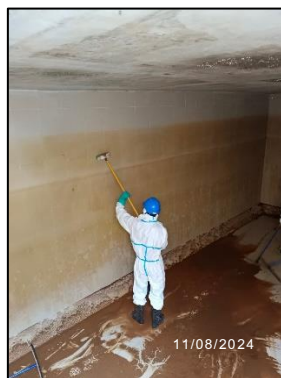
การล้างทำความสะอาดถังน้ำ Recycle ชั้น B1
