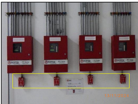
เครื่องแจ้งเหตุโดยใช่มือดึง (Fire Alarm Manual Station)
