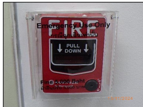
เครื่องแจ้งเหตุโดยใช่มือดึง (Fire Alarm Manual Station)
