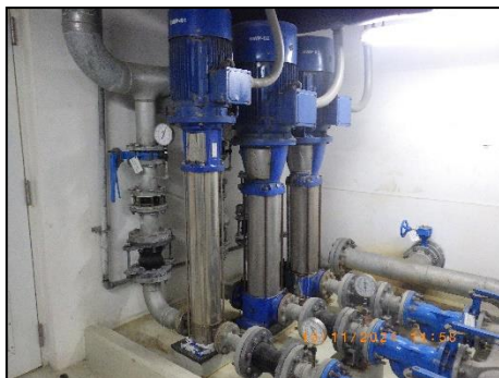
ระบบสูบน้ำรีไซเคิล
