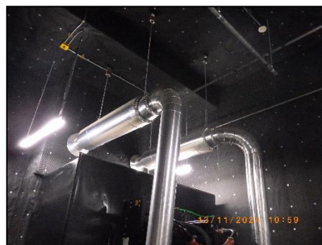
ช่องเปิดระบายไอเสียจากห้องเครื่องกำเนิดไฟฟ้า
