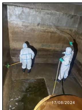
การล้างทำความสะอาดถังน้ำ Recycle ชั้น 35
